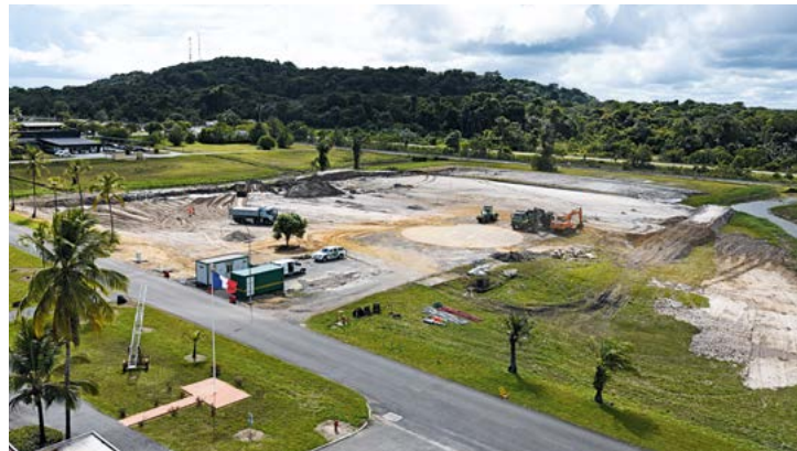
Travaux de terrassement du nouveau centre des opérations du CSG.
